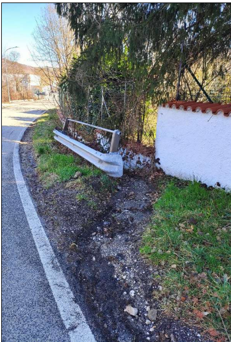
Figura 10 – dettaglio deflusso indiscriminato delle acque bianche lato destro Via San Salvatore, direzione di marcia Ovest Est
