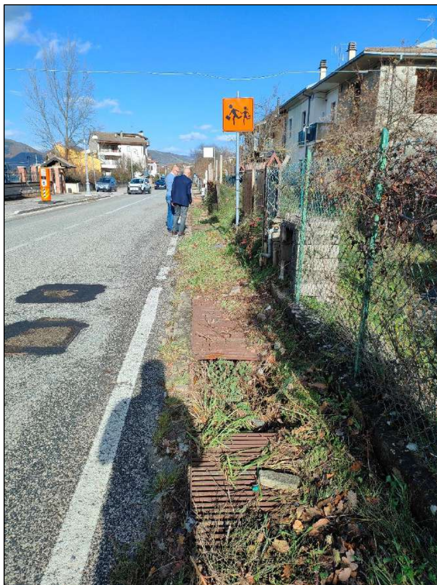
Figura 4 – Foto esemplificativa dello stato di fatto del pregresso sistema di regimentazione idraulica della via L'Aquila
